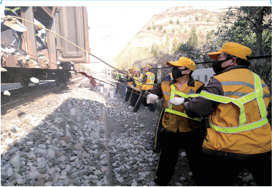
为提升设备质量,中国铁路西安局集团有限公司西安工务段每年至少集中对陇海线进行两次大修。图为3月24日该段重点维修车间职工对陇海线树园站9#道岔进行人工清筛。 通讯员 田锋力 摄
