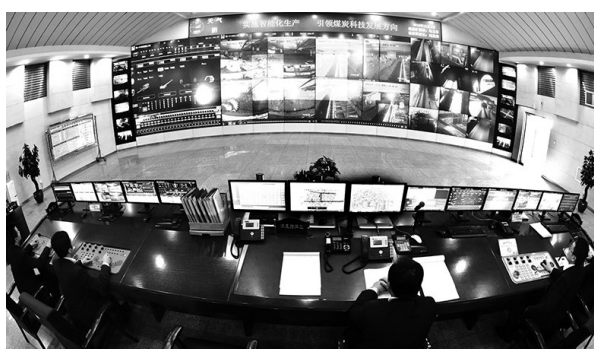
今年以来,黄陵矿业一号煤矿以打造全国一流矿井为目标,按照“总体规划、分步实施、重点突破、持续改进”的建设实施原则,在形成煤矿综合自动化系统的基础上,进行安全生产自动化系统建设,使该矿成为行业先进、陕西乃至全国领先的智能化矿井,实现安全、管理、效益的陕西乃至全国领先的智能化矿井,实现安全、管理、效益的陕西乃至全国领先的智能化矿井,实现安全、管理、效益的陕西乃至全国领先的智能化矿井。(倪小红 摄)
