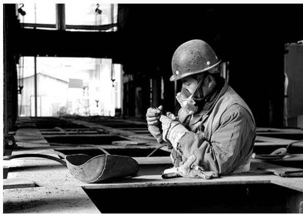
伴随着日渐回暖的气温,北元化工水泥有限公司现场一片繁忙的景象,全面铺开的二线烧成系统年度大修、余热锅炉技改等项目,都在忙碌地为全年的生产经营工作做好准备。图为施工人员正在检查焊枪,为安装新的篦冷机做好准备。马俊生 摄
