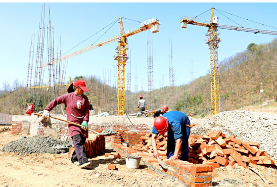
胶州新区位于宁陕县筒车湾集镇对面,总投资5400万元,其中1500万元为山东省胶州市援建资金,剩余资金由宁陕县政府出资。占地50亩,规划建设206套住房,并建设相关配套设施和胶州大桥,解决700余人的住房问题,其中,安置贫困户100户234人。目前,该项目基础处理全部完成,正在建设主体部分。 杨宁 摄
