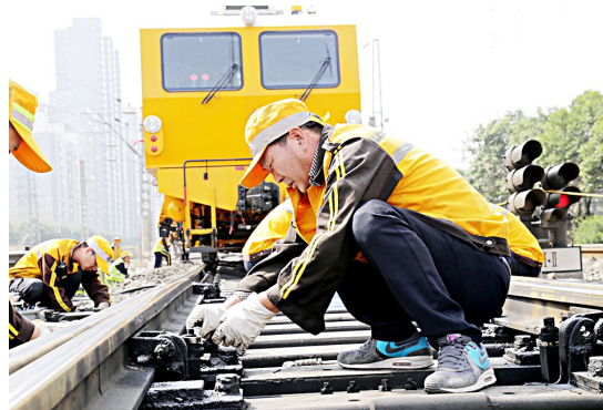
连日来,西安电务段扎实开展春季信号设备大检查大整治工作,着力消除春运期间设备高负荷运转带来的“疲惫”感,提升电务设备在季节性变化中的运用质量。图为职工在对道岔进行检查调整。 王菲 陈婷 摄
