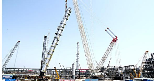
4月10日,陕西延长石油炼化股份有限公司拥有的全球唯一可拆解特雷克斯3200吨级CC8800-1TWIN履带吊,在安徽淮南中安煤制170万吨/年甲醇及转化烯烃项目中,成功整体吊装直径4米、高91.1米、重850吨的变换气吸收塔,再一次展现了延长石化大型设备吊装的实力和掌控吊装技术的能力。
