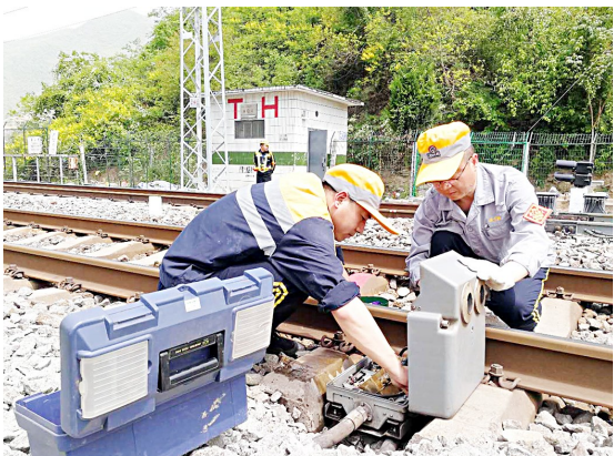
春季设备大检查开展以来,安康车辆段加强对5T设备、探伤机、天车等关键设备重点整修,及时消除隐患,全力提升质量,为车辆安全运行提供保障。图为近日该段动监车间职工在轨边整修红外线轴温探测设备。
