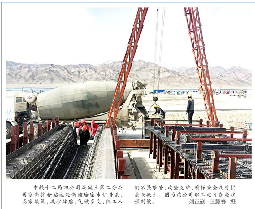
中铁十二局四公司混凝土第二分公司京新拌合站地处新疆哈密市伊吾县,高寒缺氧,风沙肆虐,气候多变,但工人们不畏艰苦,攻坚克难,确保安全及时供应混凝土。图为该公司职工近日在浇筑预制梁。
