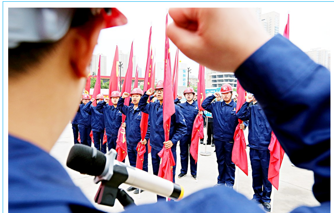
4月24日上午,随着中铁一局城轨公司承建的西安地铁临潼线(九号线)纺(织城站)-香(王站)区间右线盾构机顺利始发,标志着地铁临潼线(九号线)施工进入盾构施工阶段。图为施工人员在施工现场宣誓。陈飞波 摄
