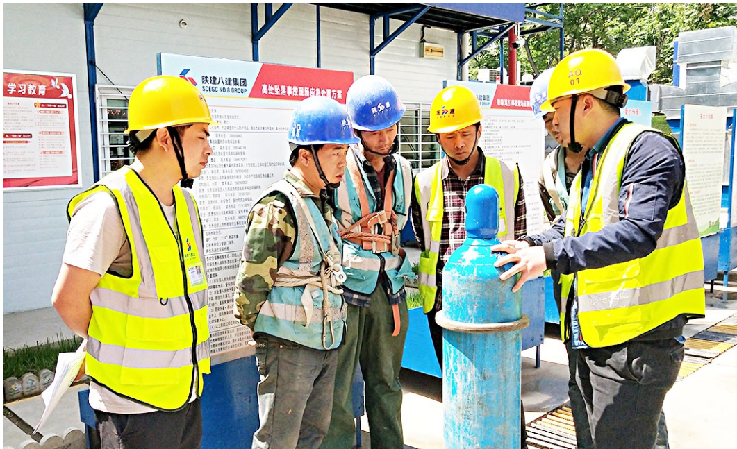
近日,陕建八建集团七公司凤城一路停车场项目部组织现场管理人员、分包单位班组长集中学习了《关于进一步加强民用爆炸物品安全管理的通知》的文件精神。图为安全员郭猛为现场工人详细讲解气瓶辨识、气瓶安全操作规程、气瓶贮存、搬运、使用安全注意事项以及气瓶回火的应急处理等知识。 李博雅 摄
