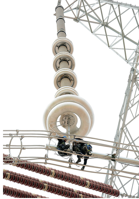
5月8日,在宁夏海原县新疆昌吉-安徽古泉±1100千伏特高压直流输电工程工地,随着最后一个连接避雷器的间隔棒安装到位,标志着西安西电避雷器有限责任公司为该工程特制的3台直流避雷器全部安装完成。 袁景智 摄
