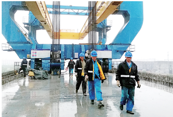
入夏以来,担负商合杭高铁河南段1214孔900吨箱梁架设任务的中铁一局新运公司,在工
