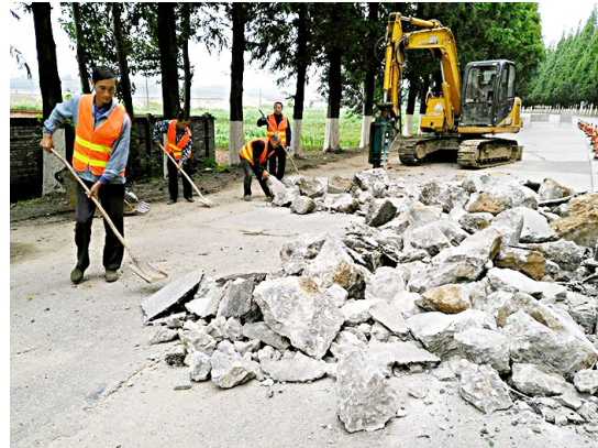
洋县公路管理段加强108国道域洋路日常养护及路面病害处置，截至5月22日，洋县段集中处置路面病害1800余平方米，保障了108国道域洋路的安全畅通。图为职工对破损沉陷的水泥路面进行破碎处置。徐立生 高峰 摄
