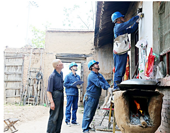
5月21日，国网铜川供电公司红土供电所工作人员来到红土镇东王村二组赵孝忠老人家里，为老人维修室内老旧线路和用电设施。井丽君 摄
