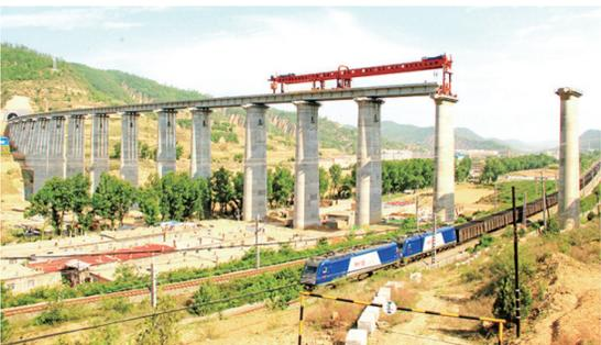
5月23日,一台双梁架桥机正在蒙西至华中铁路蒙陕段跨包西铁路特大桥高墩上架梁作业。
