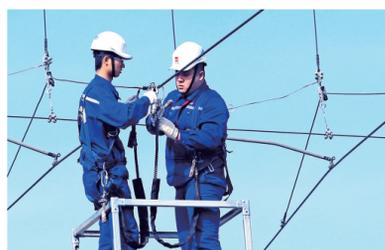
连日来,为防范高温天气对地铁供电设备安全运行的不利影响,西安地铁运营分公司以“不留死角、全面排查”为原则,对全线设备展开了“设备保障面对面,隐患排查点对点”的隐患排查工作,保障供电系统设备安全稳定运行。图为接触网专业员工正在对地铁一号线西咸车辆段的柔性接触网设备运行隐患排查。
