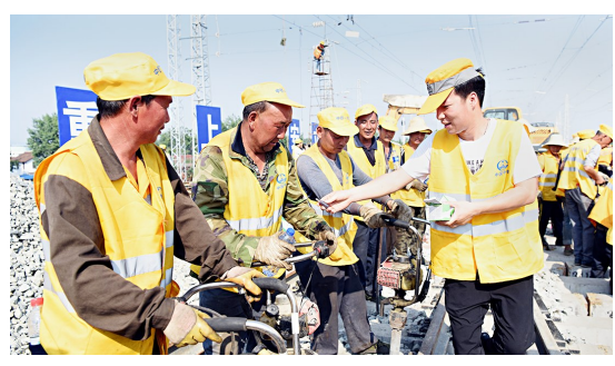
连日来,在西安铁路二号线浐河站改建工程工地,400余名一线建设者头顶烈日加紧施工。图为中铁一局铁建公司工会工作人员为一线建设者发放藿香正气水等防暑降温物品。 本报记者 刘强 摄
