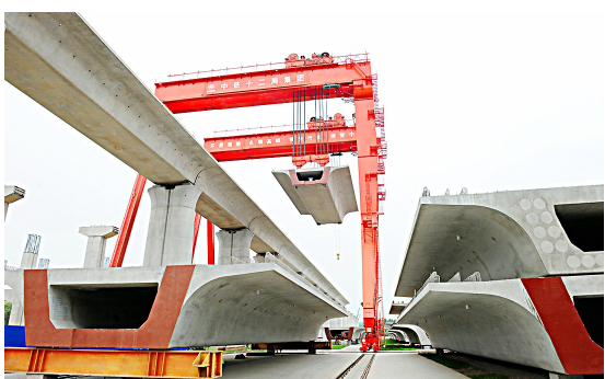
5月25日,由中铁十二局承建的京雄城际铁路大兴制梁场,使用架桥机在全长23公里的贵园特大桥上架上首榀900T箱梁。 通讯员 贾鹏翼 摄
