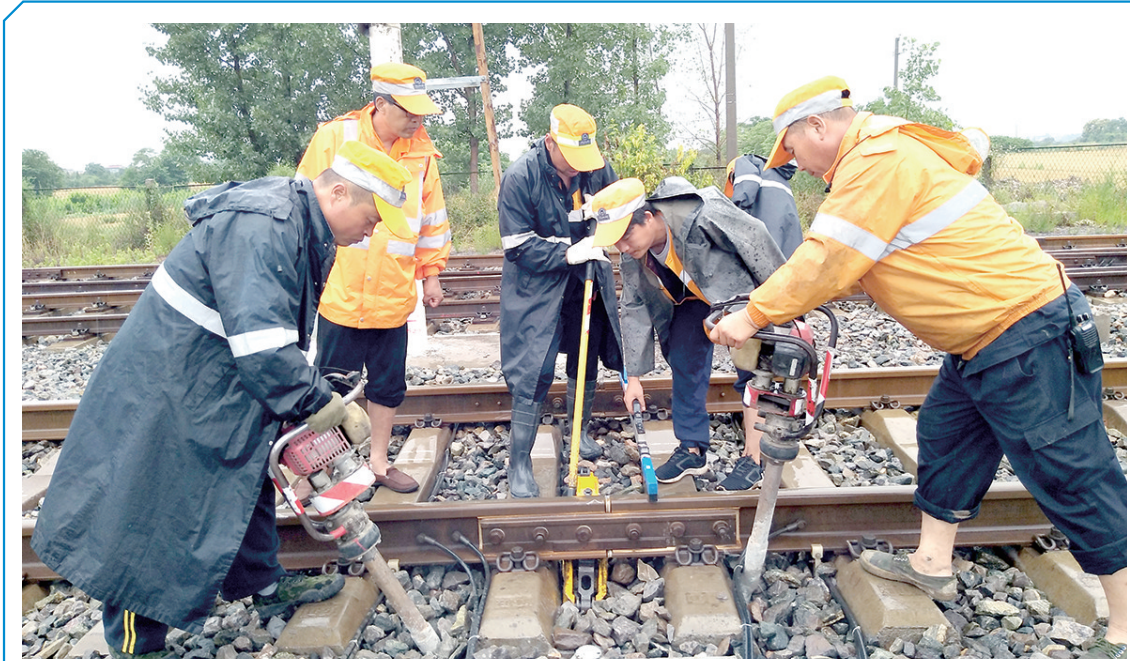
6月26日,陕西迎来强降雨天气,延安工务段干部职工严格执行“雨中、雨后”防洪巡查制度,认真巡查管内线路设备,及时发现险情,消除行车隐患。图为延安工务段蒲城线路车间职工正在冒雨对蒲城站内线路设备进行整治。□ 高参军 摄
