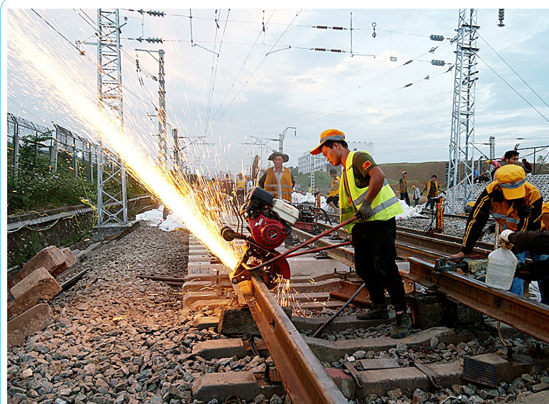
6月26日23时51分,中国铁路西安局集团公司安康东站I、II场改造施工顺利告捷,为下一步安康东至大岭铺直通线具备开通条件奠定基础。此次施工作业等级为II级,具有作业时间长、配合单位多、影响范围广等特点,施工期间
