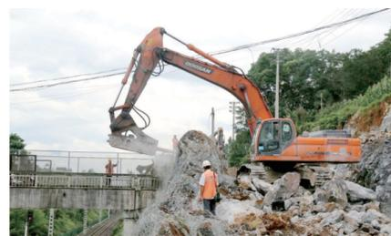
中铁二十局承建的渝怀铁路涪陵二线站前 4 标为高风险控制性路基工程, 与既有线路距离施工, 静态破除高 26 米的陡直悬崖, 采用纵向拉槽、分层开挖, 预留隔墙施工工艺。涪陵二线全体参建人员全力以赴, 确保既有运营安全。日前, 在多维监控下破除主动防护网内岩石隔墙施工, 其难度不亚于虎口拔牙。
