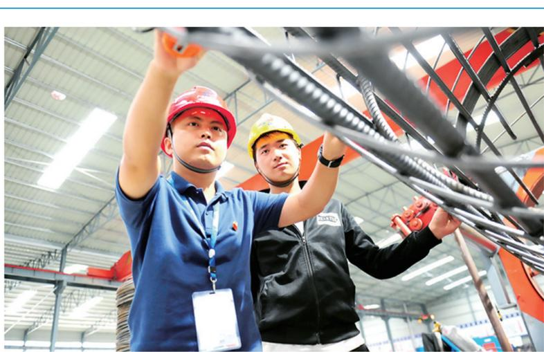
“七一”前夕, 中铁十二局在承建的广东省开阳高速公路扩改工程 T2 合同段开展了“党员形象无处不在, 党员责任处处闪光”活动。不同工种由党员和入党积极分子领衔, 确保“开工必优, 一次成优”目标实现。图为负责钢筋加工场工作的党员工程师满远鹏(左), 在现场抽查钢筋笼的钢筋布置是否符合标准。
