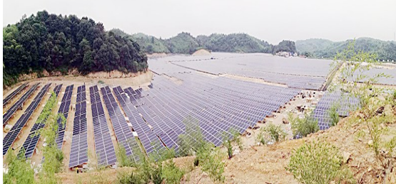
6月20日19时28分28秒,长安益阳发电有限公司尾矿库光伏项目一次并网成功。该项目是利用火电厂尾矿库(水排灰场)进行资源综合利用,在湖南尚属首次。该项目总装机容量为20MWp,并网后年平均发电量为1800万度。李昊林 摄
