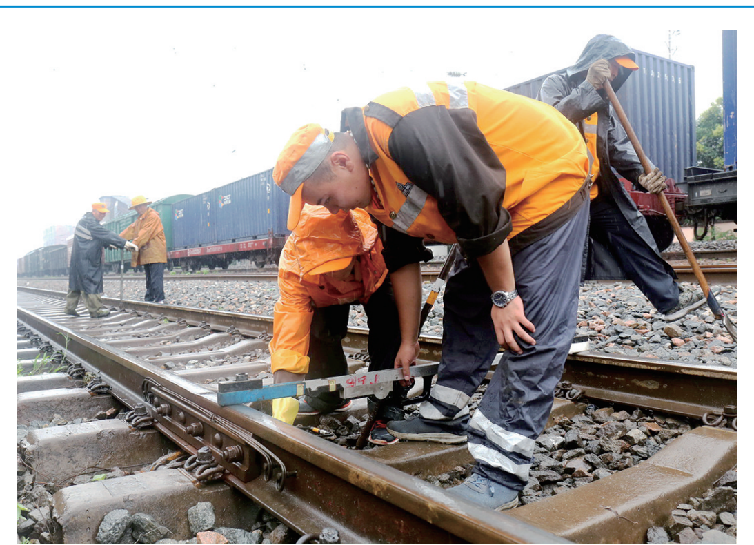
针对连日来的降雨天气,宝鸡工务段在全力做好防洪防汛工作的同时,加大对钢轨、道岔、连接零件等行车重点设备的检查整修,确保行车设备状态持续良好。图为近日该段宝天线福临堡线路工区冒雨整修线路设备。 杨晓文 摄
