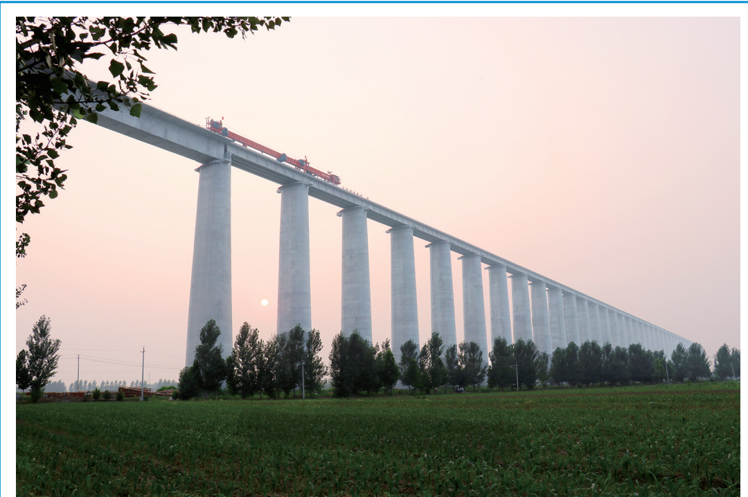
7月6日,中铁十二局集团承建的蒙(西)华(中)铁路汾河特大桥全桥合龙。汾河特大桥全长7985.38米,是蒙华铁路重难点和控制性工程之一,该特大桥的顺利合龙,为后期轨道施工以及全线开通运营奠定了坚实基础。 白凌志 陈朝辉 摄
