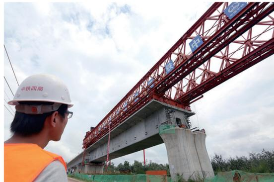
7月12日,银西高铁漠谷河2号特大桥19号墩至20号墩首孔56米预制胶接拼装箱梁最后一个节段完成拼接,这是“干拼法”施工工艺首次在国内高铁简支箱梁应用。
