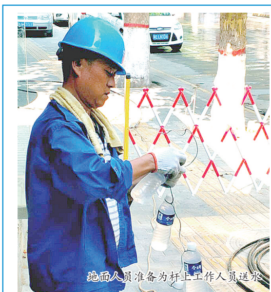
7月22日中午,华阴市岳庙西街发生电力故障导致停电,电力工作人员即刻行动,冒着38℃以上的高温经过3个多小时的紧张抢修,终于恢复了电力供应,炎炎夏日为市民群众送来了凉爽。王渭 摄
