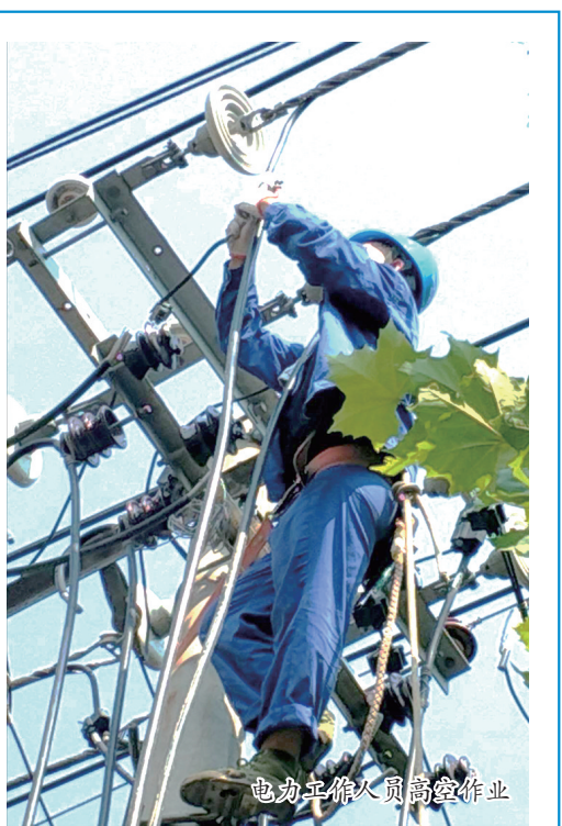
电力工作人员高空作业
