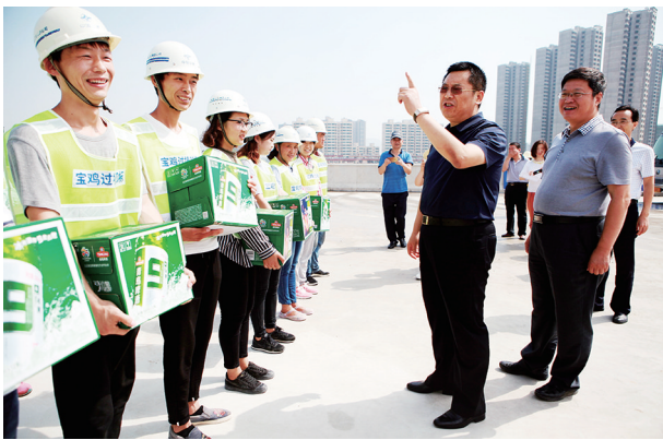
7月26日上午,宝鸡市政协主席白升安带领市政协慰问团一行共26人,来到宝鸡过境公路项目建设工地现场,看望慰问冒着高温奋战在建设一线的施工人员,并送上宝鸡市委、市政府的关怀,为他们送去防暑降温物品。魏茸 摄
