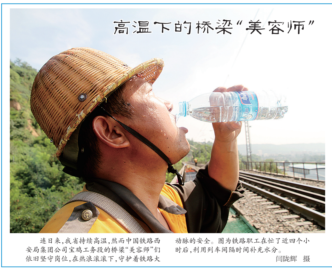
连日来,我省持续高温,然而中国铁路西安局集团公司宝鸡工务段的桥梁“美容师”们依旧坚守岗位,在热浪滚滚下,守护着铁路大动脉的安全。图为铁路职工在忙了近四个小时,利用列车间隔时间补充水分。 闫晓辉 摄
