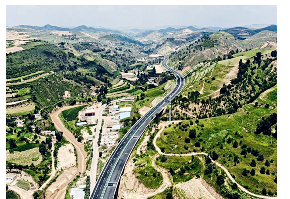
日前,吴(起)定(边)高速公路建设已进入收尾阶段,预计今年9月建成通车。据了解,吴定高速全长92.217公里,设计时速每小时80公里。 顾小星 摄
