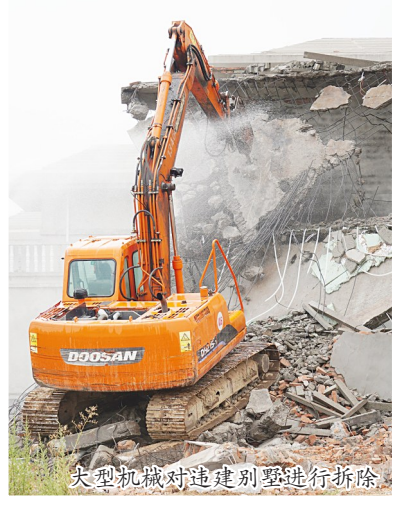
大型机械对违建别墅进行拆除
