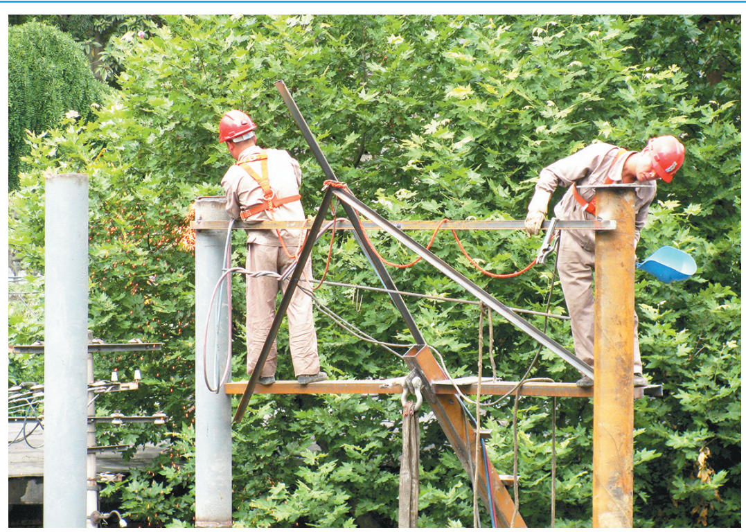
汉中嘉陵矿业公司黑山沟分公司针对暑期天气炎热,职工安全意识淡薄、劳动纪律易松懈的实际,及时查纠劳保用品穿戴不规范行为,确保安全生产持续稳定。图为近日规范佩戴安全带人员正在高空作业。唐旭波 摄
