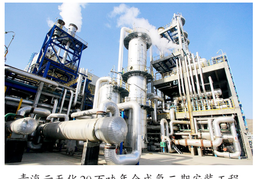
青海云天化20万吨合成氨二期安装工程
