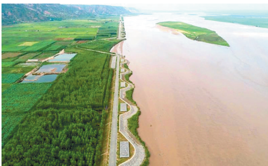
位于合阳百良镇榆林村境内的榆林工程是黄河防护的一部分。据了解，该工程始建于1985年，全长4299米。主要为控制河势西倒，保护沿黄村镇人民生命财产安全，同时改善榆林湾进流条件。韩博磊 摄
