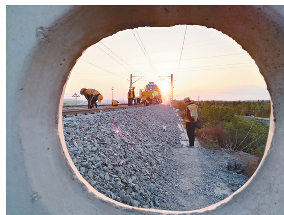
入秋以来,针对室外道岔设备易引发季节性惯性故障的实际,中国铁路西安局集团有限公司电务段提前着手,对信号设备进行“拉网式”排查整治,及时将设备隐患消灭在萌芽中,确保铁路运输安全。图为日前该段靖边信号工区职工正在整治道岔。 禹静 摄
