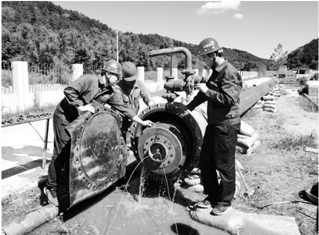
日前,神渭管运公司顺利完成黄龙至蒲城站间收球筒装置压力试验和变径通球试验,为今后两个站间管线下通球清管、几何测径、充水试压工作的开展打下了良好基础。刘团 周宇 摄
