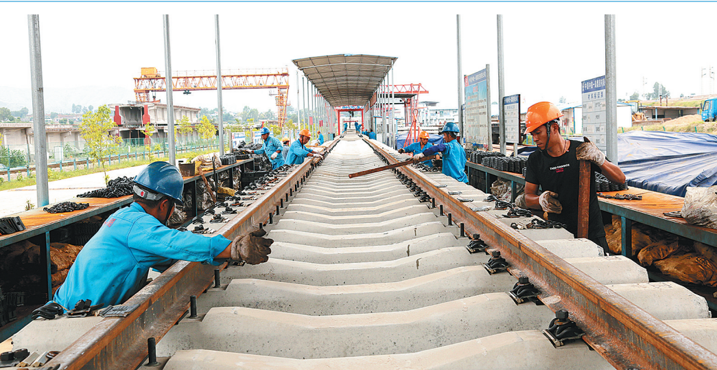
中铁一局新运公司永广项目部把安全工作落到实处,形成了职责明确,管理科学,运转高效,规范有序,奖罚分明的安全
