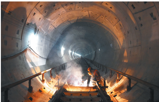
9月27日，由中铁一局承建的西安地铁一号线二期轨道工程正在加紧施工。据了解，该工程正线全长6.1公里，设森林公园站、沣东路站、上林路站、张家村站。
