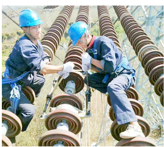
国庆长假期间,陕西送变电工程有限公司西安电力安装工程处职工奋战在±800千伏灵绍线更换绝缘子。 王小侠 典安仁 摄
