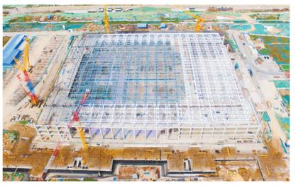
10月8日,在陕建一建集团承建的西安奥体中心游泳跳水馆项目工地,随着工程指挥员的一声令下,长168米、宽120米、重达3000吨的大型屋盖钢架成功就位,标志着该工程正式封顶。杨磊 刘建刚 摄
