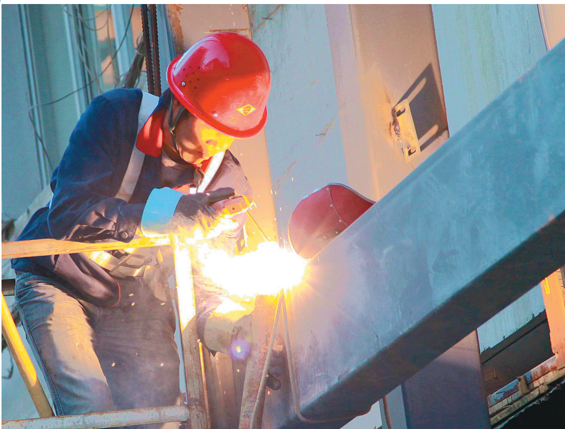
陕建集团总承包的延安城市“双修”(生态修复、城市修补)一期项目是延安老城改造的重大工程。近日,陕建八集团在负责延安二道街环境整治治项目中,开展了“大干四十天、助力城市‘双修’、刷新延安‘颜值’”活动,现场施工人員你追我赶,到处一派紧张、繁忙的施工场景。
