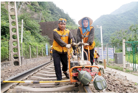
连日来,中国铁路西安局集团公司宝鸡工务段利用大型机械捣固车对宝成线的轨道线路进行机捣作业,确保行车安全万无一失。图为该段重点维修车间职工正在进行校核检查。 通讯员 闫院辉 摄
