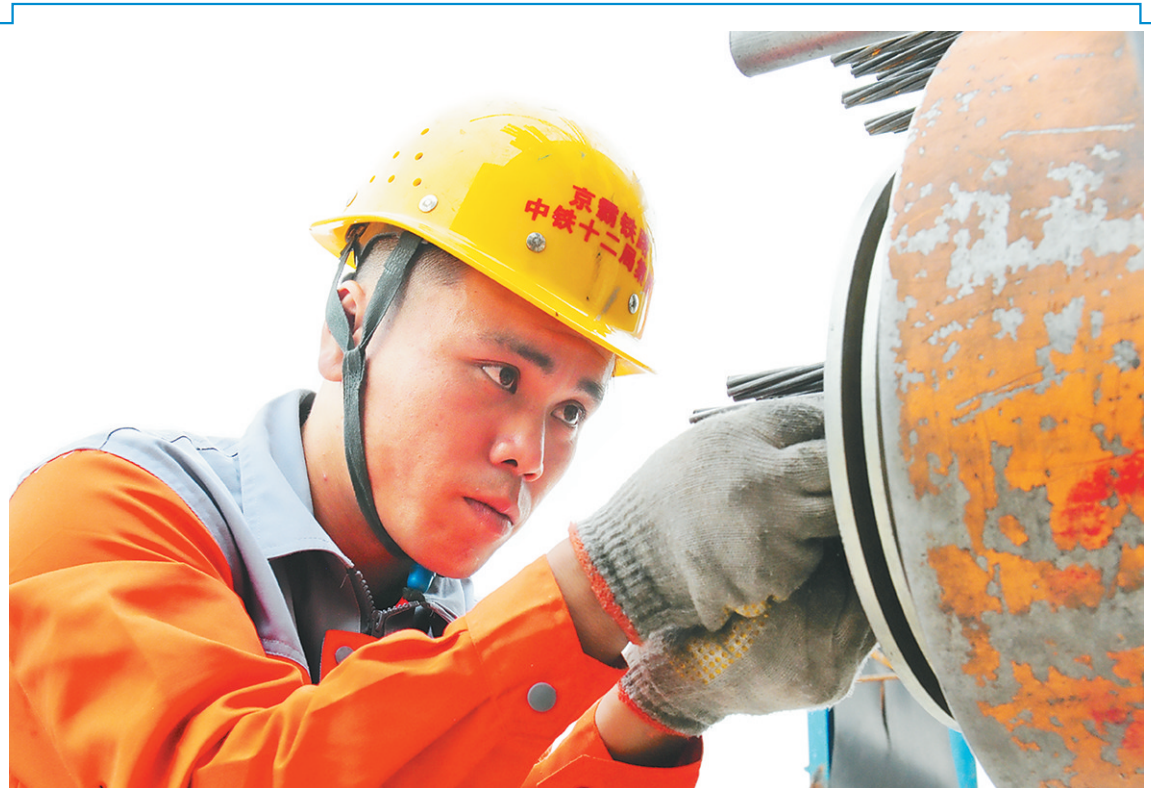
中铁十二局京雄城际铁路1标大兴制梁场承担着全线538榀制梁任务,他们积极开展“我上岗,我工匠”“我与梁场共荣辱”活动,采取职工夜校、导师
