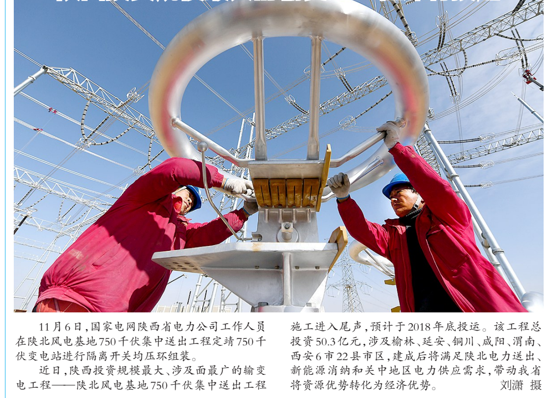
11月6日,国家电网陕西省电力公司工作人员在陕北风电基地750千伏集中送出工程定靖750千伏变电站进行隔离开关均压环组架。
