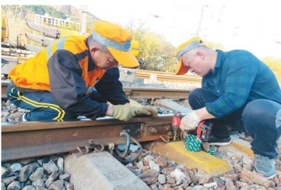
近日,随着气温逐渐降低,昼夜温差大容易给信号设备造成隐患,为此宝鸡电务段组织车间采取积极措施,对管内各个站的抗流线圈进行统一测试、检查,在巡检过程中发现外皮破损、电流数值不符标准的及时更换,确保以“崭新的装备”不冬达不到内外美的要求。 □王静 摄
