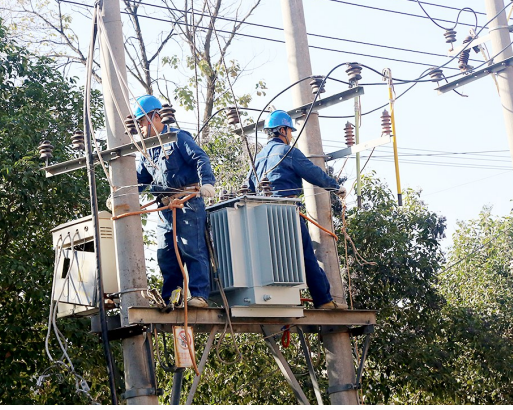
11月21日,国网西安临潼区供电公司员工在铁炉初级中学增容变压器1台,及时保障了校区千余师生取暖用电,受到该校师生的好评。 潘世策 摄
