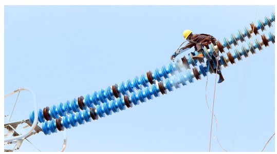
11月30日,在延安富县风电750千伏集中送出工程富县750千伏秦道变电站,一名建设者攀登到距离地面40多米高的绝缘子上喷涂防水、防尘涂料。据了解,该变电站将于12月10日正式投用,运营后将把陕北的光伏、风电等清洁能源输送到关东地区。 本报记者 刘强 摄
