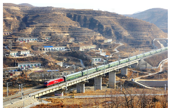
铁路是经济社会发展的大动脉,改革开放40年来,榆林革命老区境内的铁路总里程已超一千多公里,老区人民也从期盼火车开进城,实现了今天出行更加安全、便捷、舒适的愿望。11月27日,一趟列车行驶在太中银铁路绥德段。
