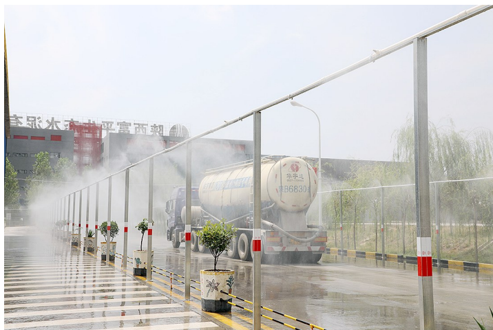
生态水泥公司厂区内全自动除尘设备正在进行喷淋作业
