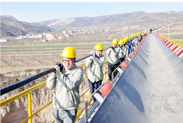
生态水泥公司职工正在进行矿山皮带长廊电缆铺设
