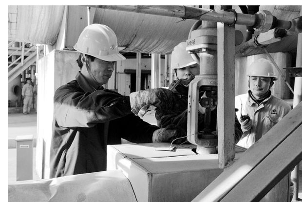
近日,神木天元东鑫垣公司以防患于未然的安全环保理念为指导,模拟发生加氨装置高压串低串事故进行了安全演练。图为仪表检修组处理失灵调节阀。张敏娜 摄
