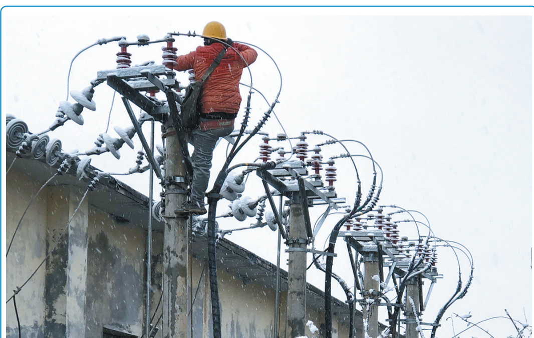
12月13日，中铁二十局电气化公司西安二号线后工程指挥部电力专业施工人员在雪中为宁强配电站安装及调试隔离开关。为确保西安二号线2019年开通目标的实现，该项目全体参建职工在“大战四季度保开通”劳动竞赛中克服低温、霜冻等困难，向既定节点工期发起最后冲刺。 通讯员 肖艳鹏 李缘圆 摄
