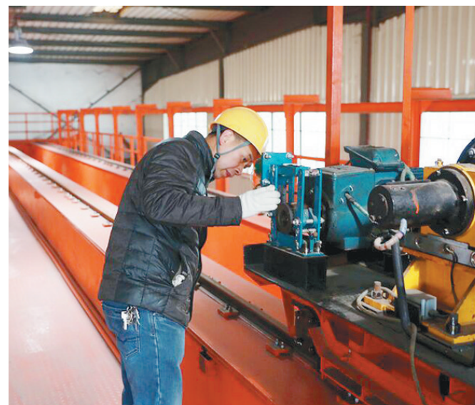
12月12日至14日,中国铁路西安局集团公司安康车务段工会组织职工代表,开展为期两天的劳动安全巡视检查。图为该段职工代表在劳动安全巡视检查现场。刘云鹏 摄
