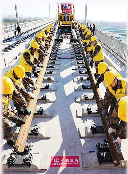
←在京张高铁河北怀来段铺轨现场,中铁三局的工人铺下京张高铁全段第一节轨排。
